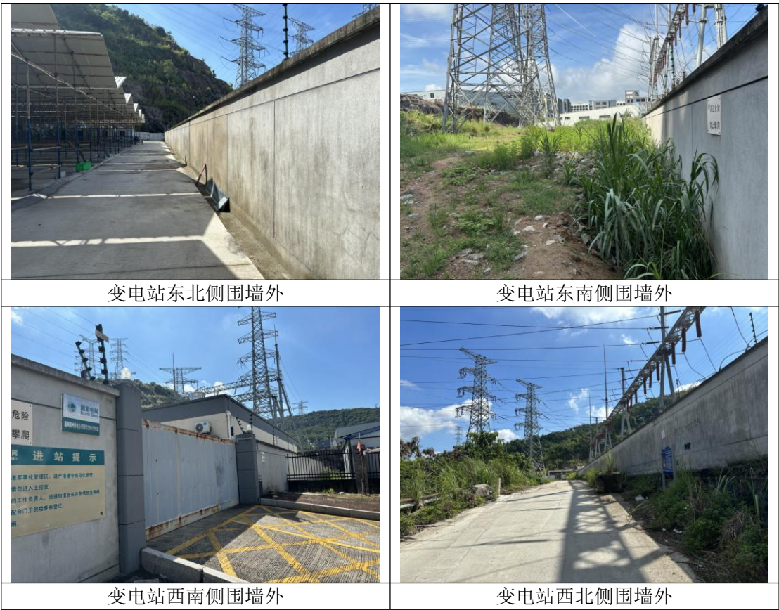
图2-1 瑞归220kV变电站周边现状图
